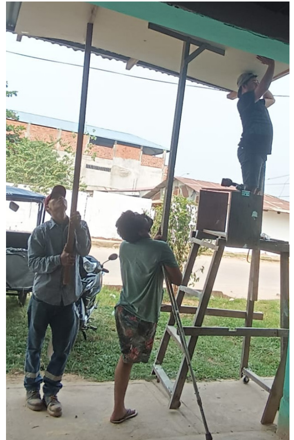
Einbau der Deckenplatten
